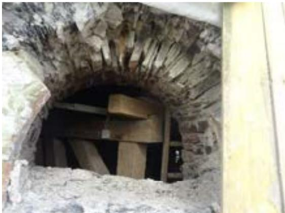
*(Ausbau schadhaftes Mauerwerk und Sandstein im Turm)*
