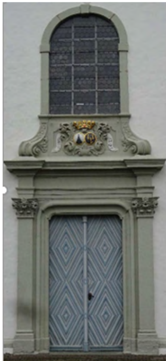
(Auch das Eingangsportal der Kirche wurde umfassend saniert.)
